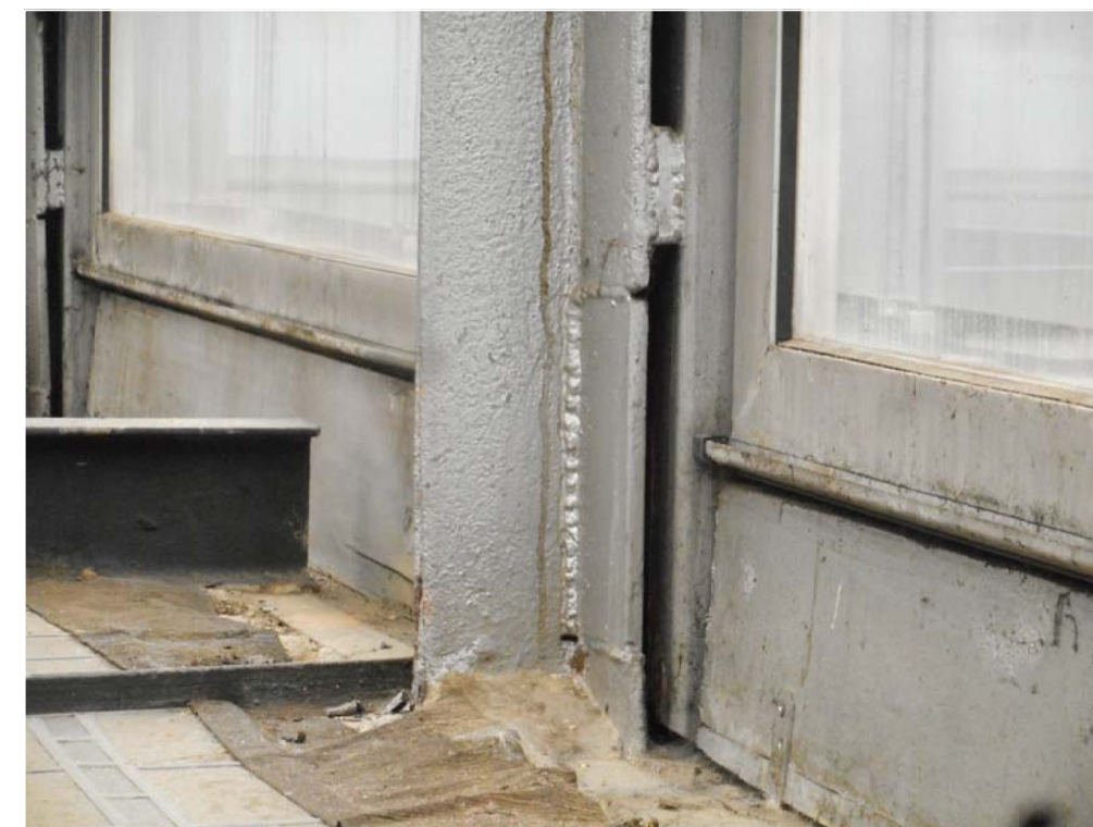
Injertos realizados en las bases de los pilares
